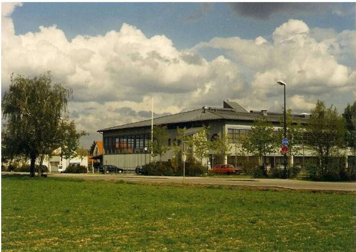
NEUE HALLE an der Alfons-Baumann-Straße fertiggestellt und bezogen 1992
